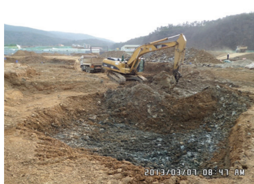
터파기 및 치환
