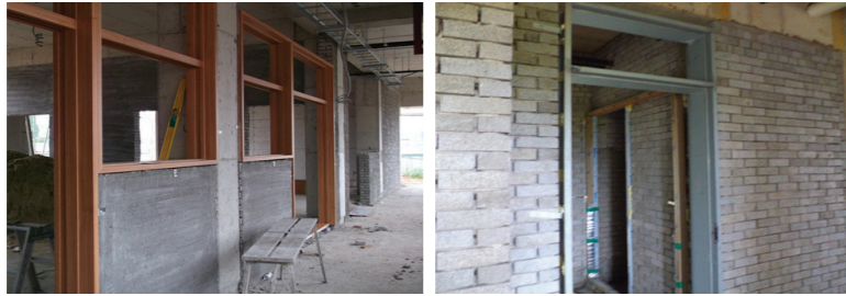
목문틀 시공 사례
