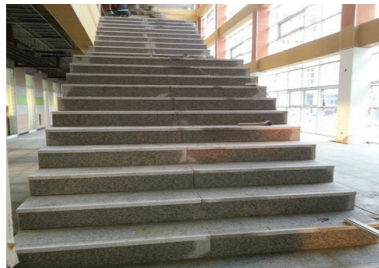
중정계단 화강석판재 시공
