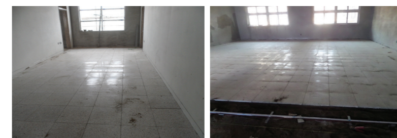
홀, 복도 테라조타일 시공
