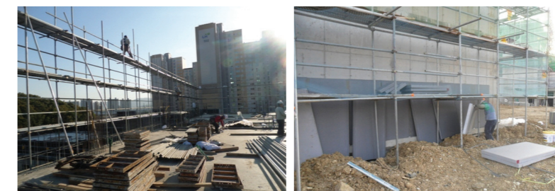
외부비계 및 작업발판 설치
