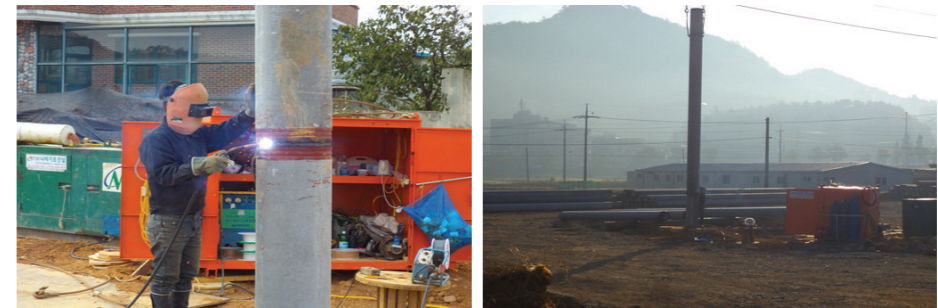
기초파일 이음밴드 용접
