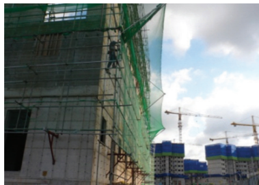
외부 낙하물방지망 설치
