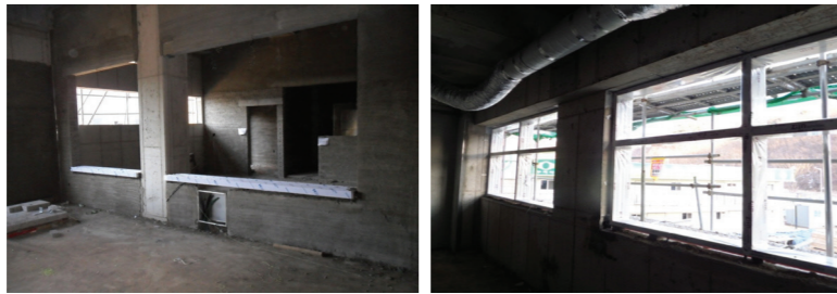
개구부 스텐프레임 설치
