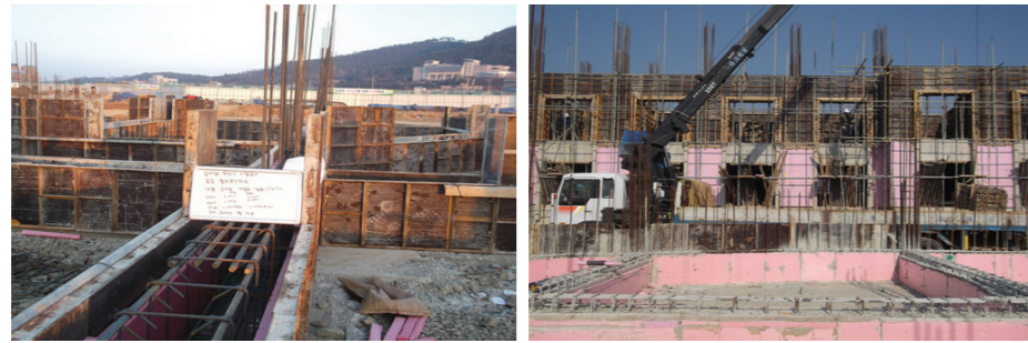
지중보 합판거푸집 설치
