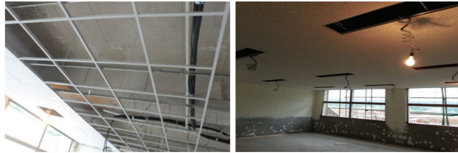
경량철골 천장틀 설치
