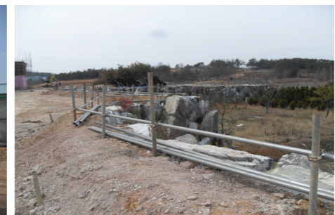
가설울타리 지주목 설치
