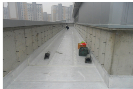
옥상 시트방수 시공
