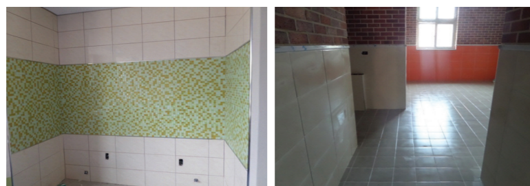
타일 압착공법 시공
