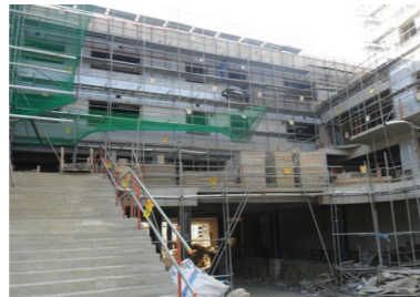
외부계단 화강석판재 시공
