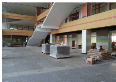
홀 화강석판재 시공
