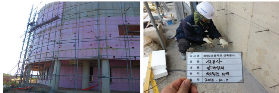
벽체용 앵커 설치
