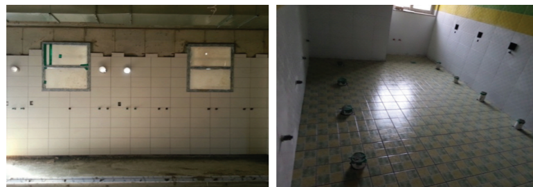
타일 구멍뚫기 시공
