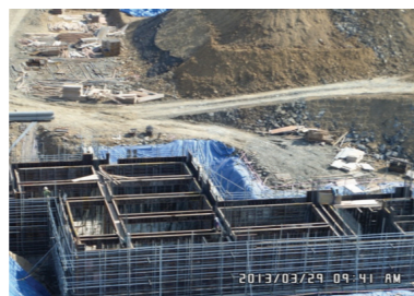
외부 안전난간 설치
