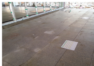
주출입구 화강석판재 시공
