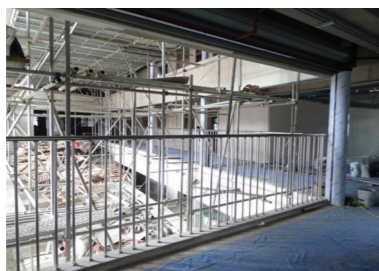
안전난간대 설치
