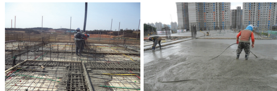
바닥 콘크리트 부어넣기
