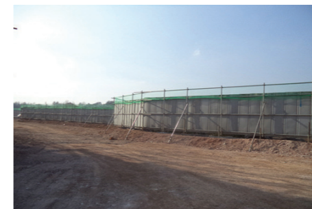
가설울타리 및 분진방지망 설치
