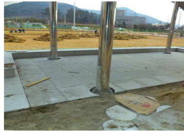
조희대 화강석판재 시공
