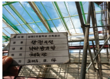
지붕 낙하물방지망 설치
