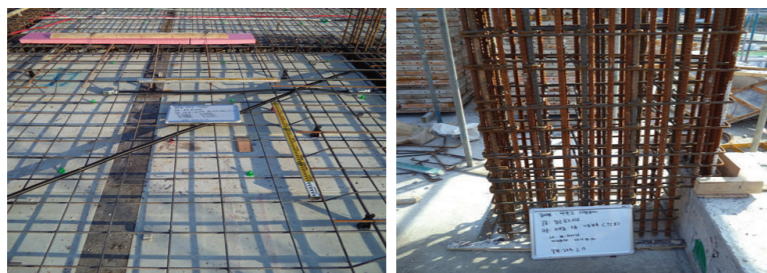
바닥보 철근가공 및 조립
